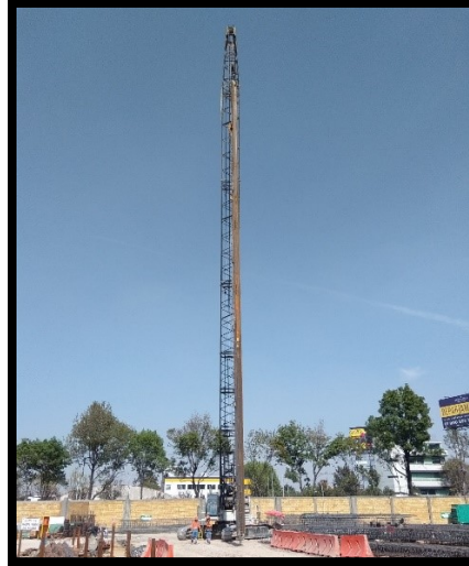
Figura 22 Desplante de perfil pre-cimentado
