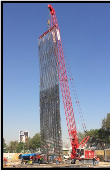
Figura 16 Desplante de muro Milán
