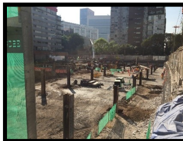
Figura 31 Construcción de Planta Baja
