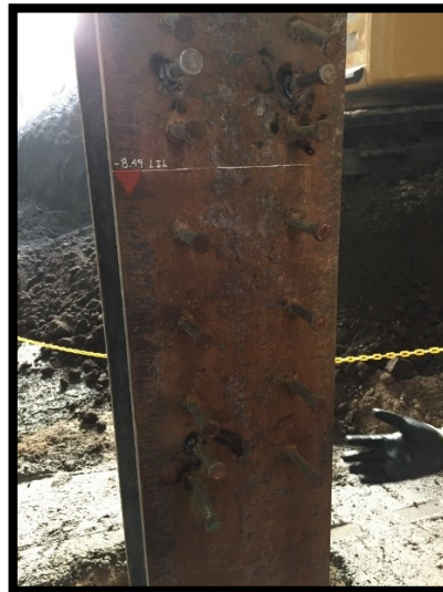
Figura 23 Conectores de cortante en perfil pre-cimentado
