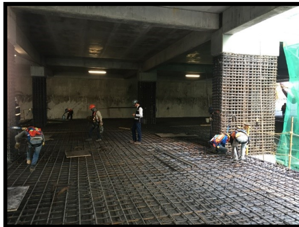
Figura 28 Losa de sótano
