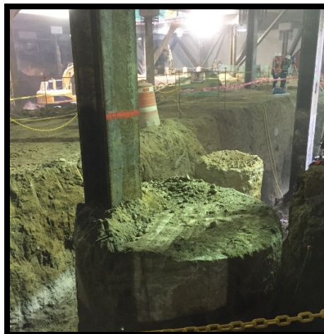
Figura 20 Pila con desviación mayor a la considerada en proyecto
